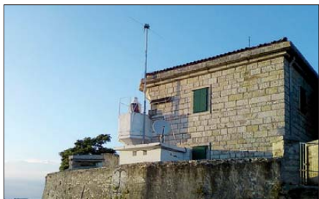
Der idyllisch gelegene Leuchtturm „RT Zub“ an der kroatischen Küste mit der typischen CODAR-Groundplane-Antenne
