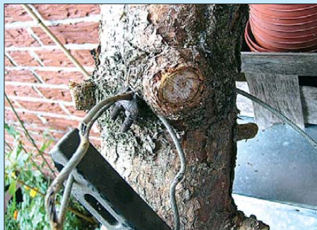
Bild 67: Wo ein Baum als Abspannpunkt benutzt wird, bedenke man, dass dieser bestrebt ist, über die Jahre seinen Umfang zu vergrößern. Ein Vergessen der jährlichen Inspektion kann Folgen haben, wie sie auf diesem Bild zu sehen sind. Foto: DF8XR (tnx!)
