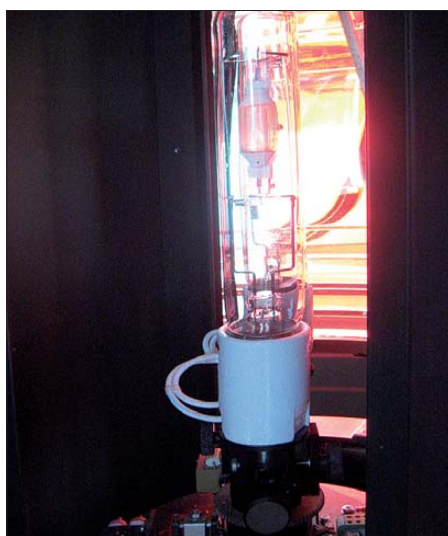
Eine der beiden 400-W-Lampen des Leuchtturms
